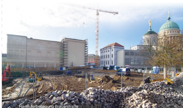
Haveluferbebauung Brauerstraße (Foto: A-ST)
